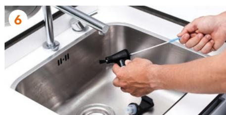
6 Démontez la partie supérieure du robinet et nettoyez l'intérieur avec le goupillon fourni à cet effet.
